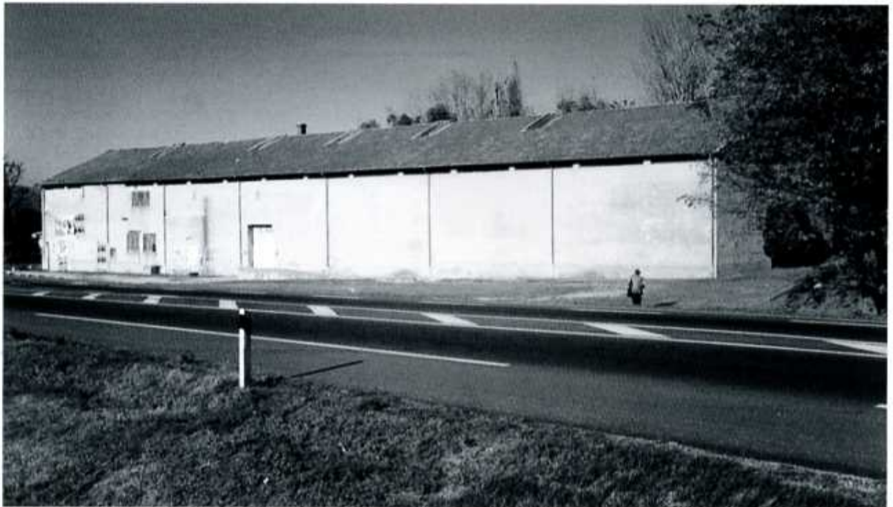
Façade ouest du bâtiment actuel, seul restant de l'ancienne usine, à l'est de la déviation sud de la RN 7 de Loriol. On remarque l'absence de fenêtres murales et les verrières zénithales, seules sources de lumière. Photo J. Sauvageon
