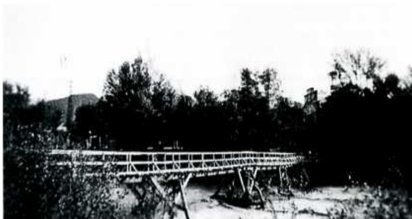
Passerelle provisoire construite à Crest pour suppléer au pont détruit le 24 juin 1940. Photo, datée du 2 novembre 1942, prise depuis la rive droite. (coll. Maria Carity).
