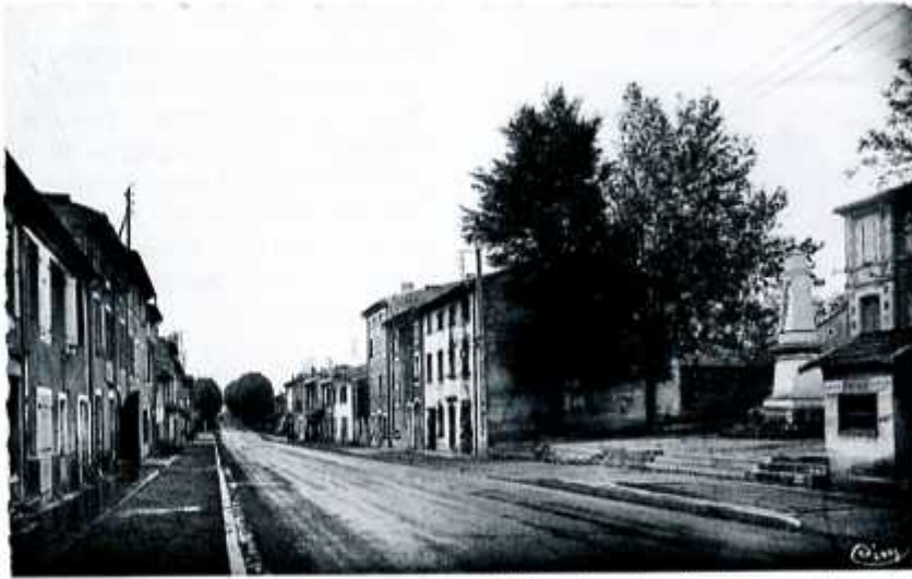
Au bord de la RN7 vers le Sud (en bas de la carte postale). A droite, le poids public, le monument aux morts devant la mairie et, derrière les arbres, la maison de Louis Laurent dont la façade porte encore la marque de l'incendie d'août 1944 (carte postale Jean Bouyon).
