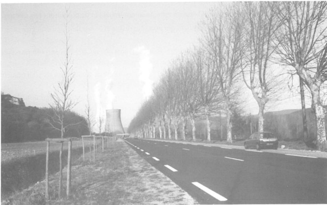
Sur la route nationale 86, au sud de la centrale nucléaire de Cruas, un alignement de platanes a été conservé, après la création de deux larges accotements et le deuxième alignement reconstitué.
