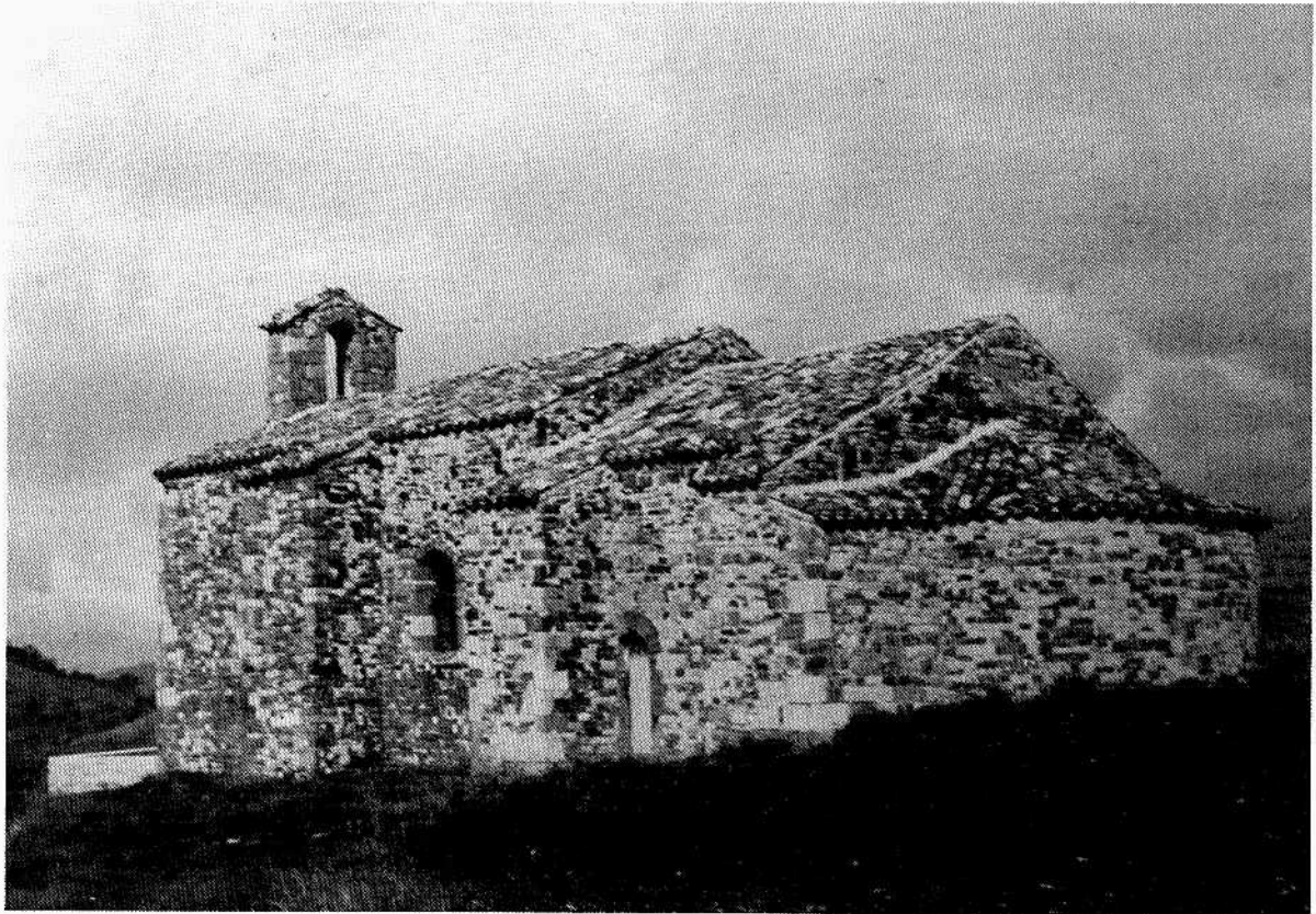
EGLISE DE CRUPIES : massive, lourde avec son petit appareil, ses énormes contreforts, son abside écrasée, elle évoque une époque plus lointaine que celle de sa construction.
