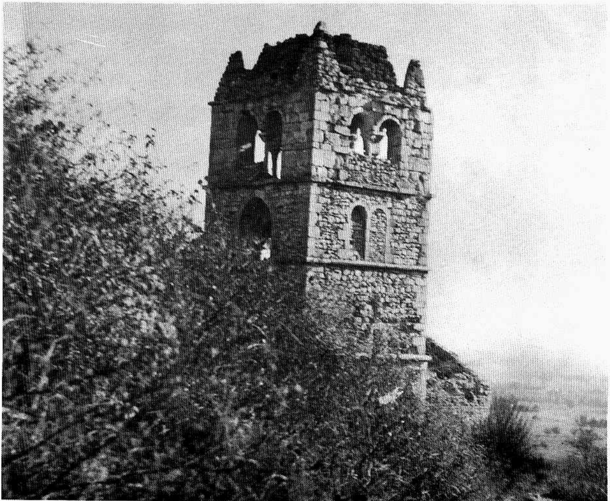
RUINE DE St FELIX DE MARSANNE : chacun des quatre étages est souligné par un cordon. Malgré la mauvaise qualité du matériau (gélif), cette tour se maintient comme les murs du château qui la jouxte, grâce à un blocage massif, et aux chaînages d'angles faits de pierre dure. Les acrotères pyramidiaux et la flèche sont en tous points semblables à ceux du vieux prieuré de Roinac, tout proche. Le site domine les territoires de plus de vingt communes.
