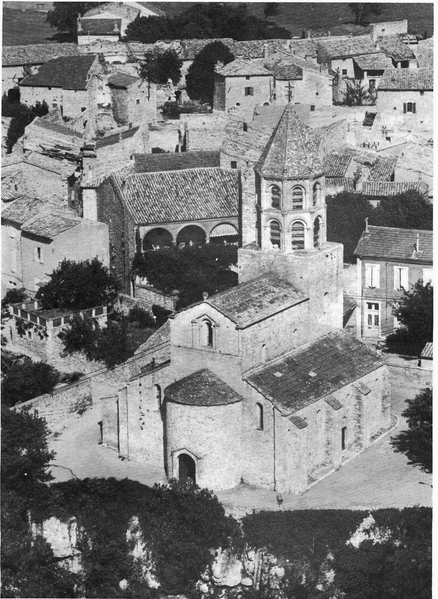
L'ÉGLISE DE LA GARDE-ADHEMAR : Elle s'élève au dessus de la plaine tricastine, dans un environnement bien provençal. On voit ici l'abside occidentale et la progression harmonieuse et sobre des élévations successives des masses jusqu'au clocher qui s'affine, du plan carré au plan octogonal.
